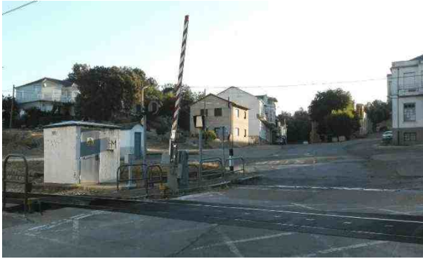
El Paso a Nivel en Vega de Magaz
