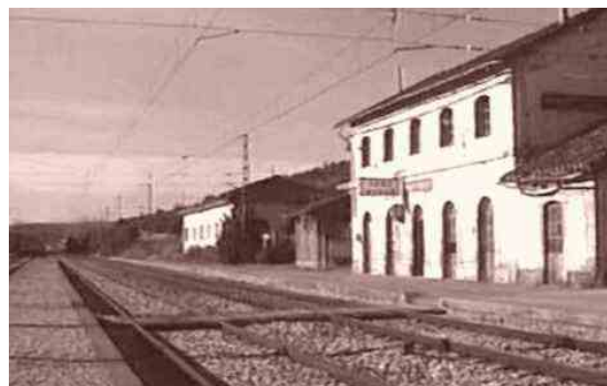
Antigua estación de Vega de Magaz
